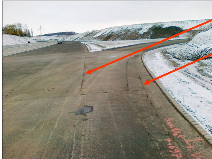
Keine Fugen im Gussasphalt **unter OPA** ausgebildet.
