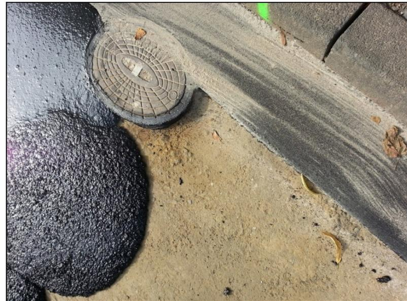
Einbau des TOK<sup>®</sup>-Band an Gussasphalt.
