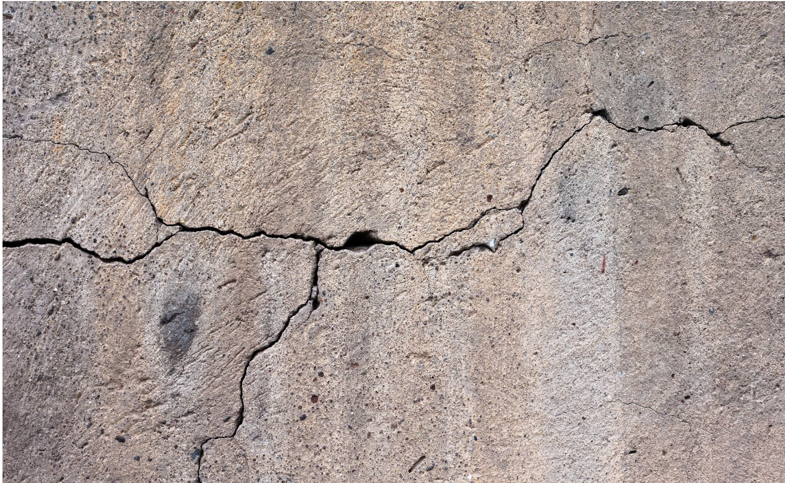
Risse im Beton
