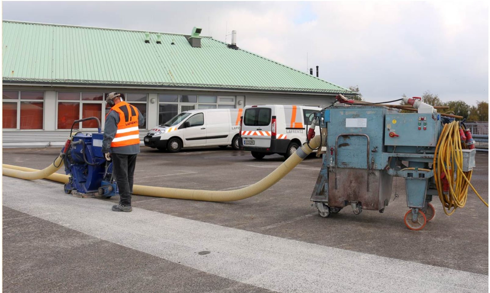
Kugelstrahlmaschine
