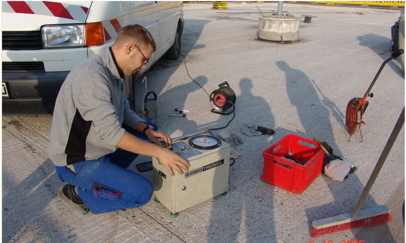
Haftzugprüfung mit Haftzugprüfgerät
