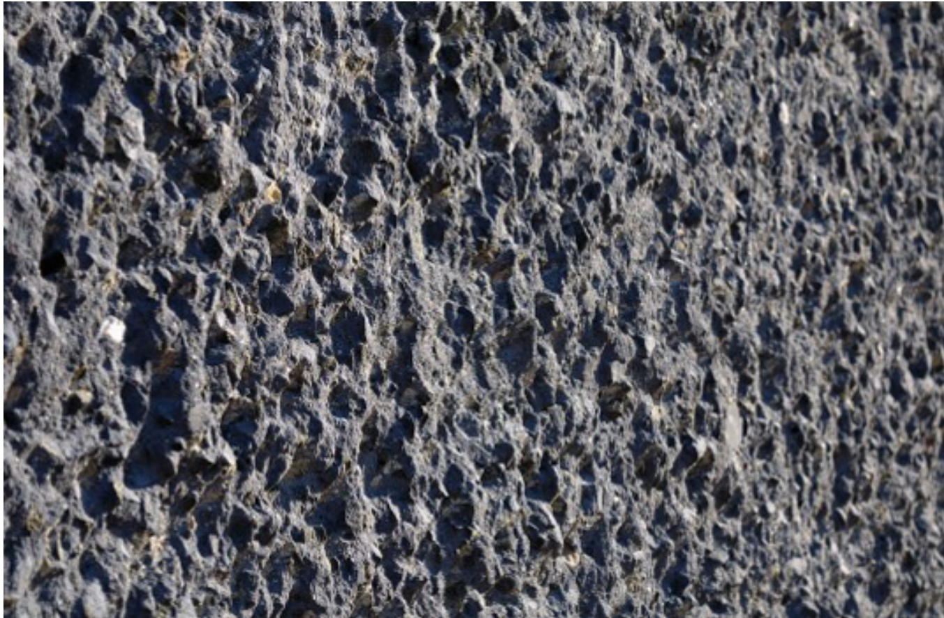
Zu große Rauigkeit einer Betonoberfläche
