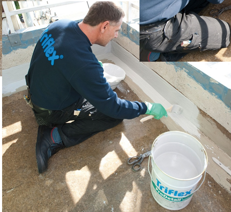
... vliesarmierte Abdichtung der Anschlüsse + Details
