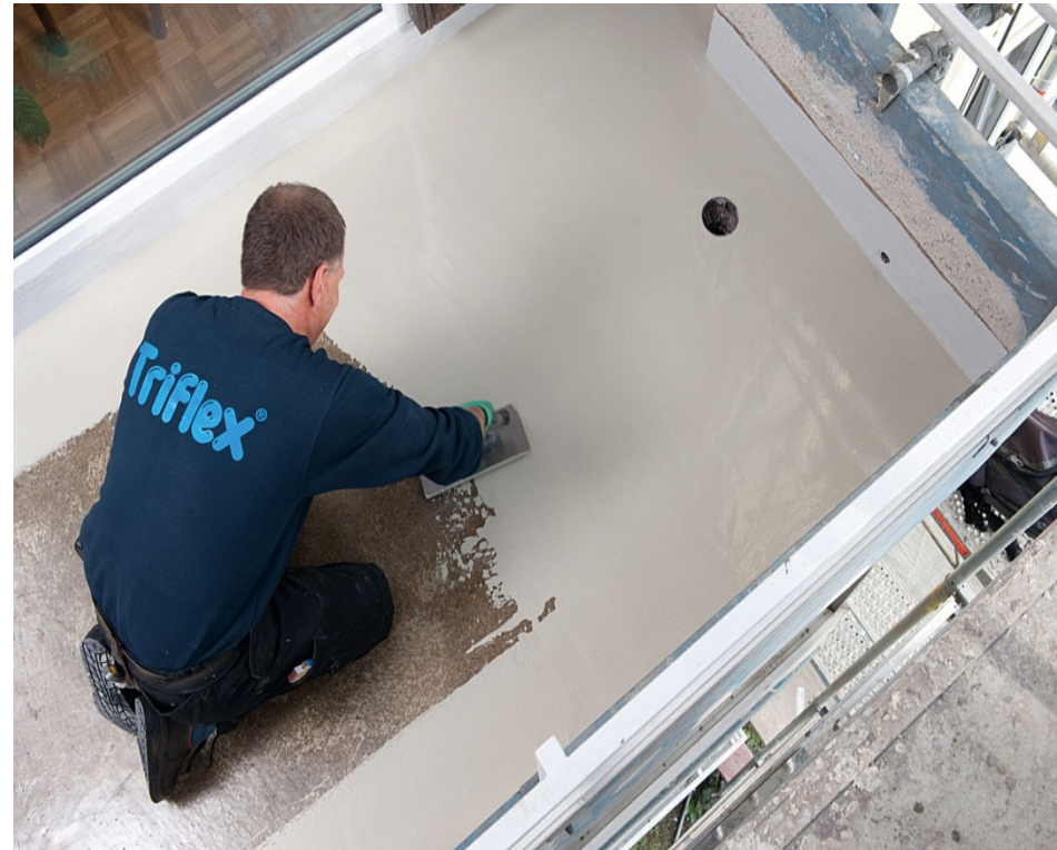
Aufbringen der vliesfreien Beschichtung
